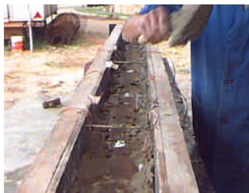
(b) moldagem da viga VC-1
