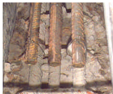
(b) armadura de reforço da VA-3
