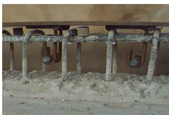
(a) armadura de reforço da VC-2
