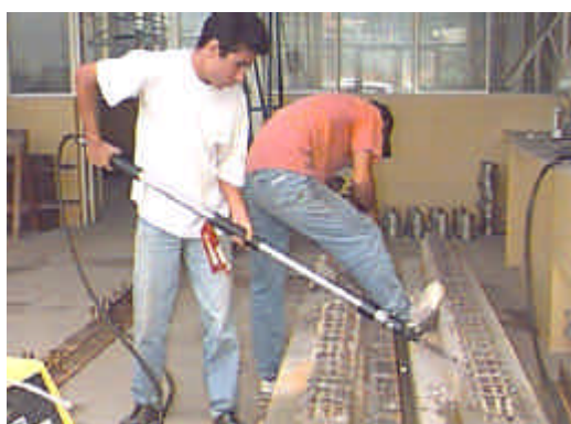
(a) escarificação da superfície com martelete pneumático
